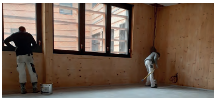
Chantier réalisé avec le système VERNIS A650P / A651P
