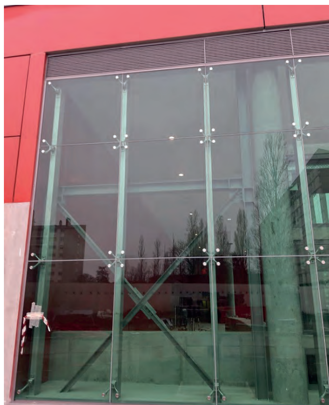
Chantier réalisé avec le système 421 KS
