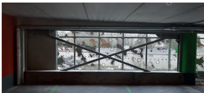
Chantier réalisé avec le système 421 KS
